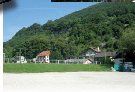
Affleurements rocheux pouvant provoquer des chutes de pierres
