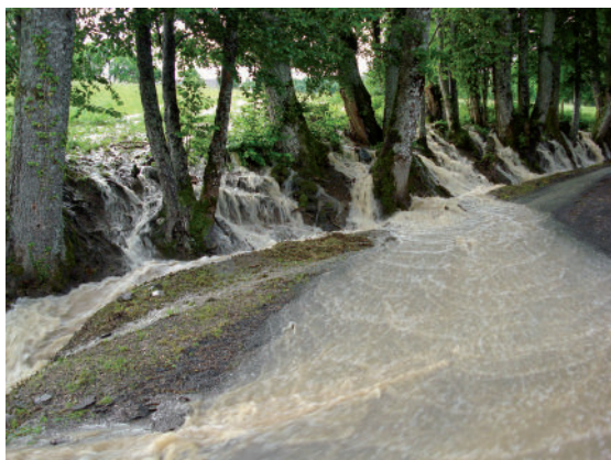
Débordements torrentiels sur la commune de La Muraz (16/06/2008) (clichés : Mairie de La Muraz)
